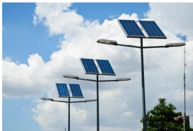
Figura 7: Postes de iluminação autônomos alimentados por módulos fotovoltaicos.
