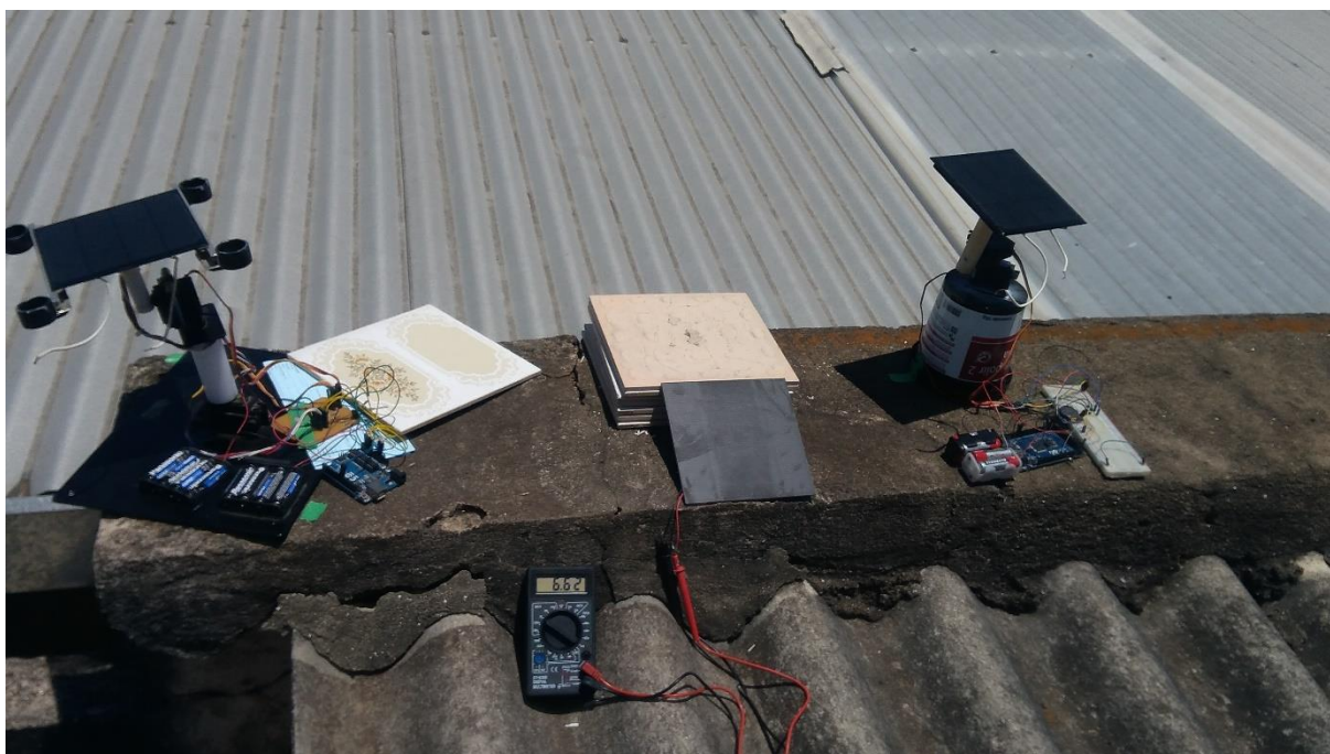
Figura 31 - Testes de campo dos seguidores solar.
