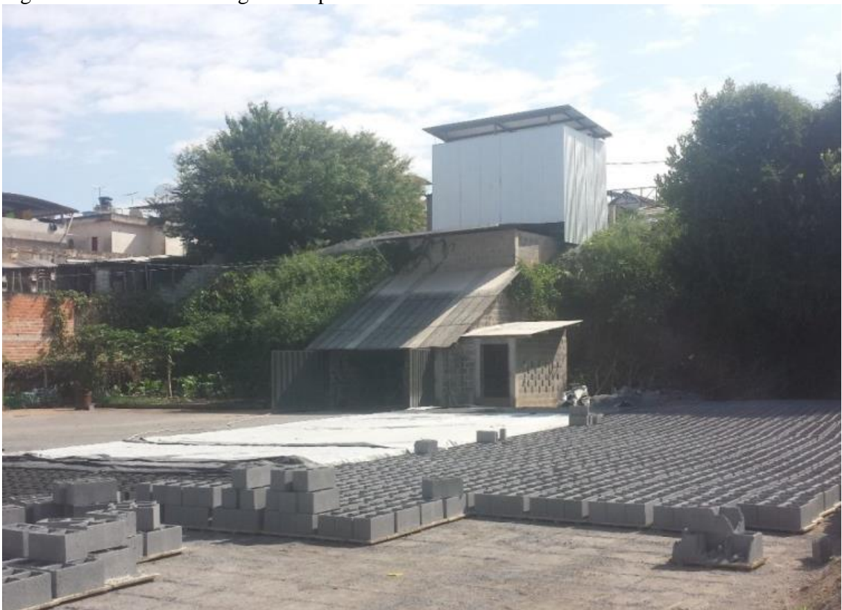
Figura 8 - Terreiro de secagem dos pré-moldados
