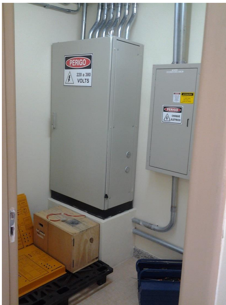
Figura 15 - Vista da sala Técnica.
