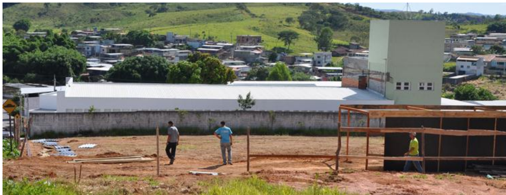
Figura 3 – Obras para a construção do futuro Bloco 'C'. (Fonte: IFMG, 2014).
