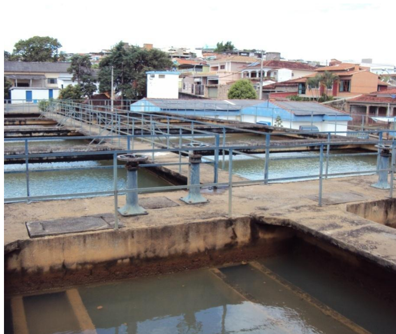
Figura 9 - Tanques de decantação e filtragem. Fonte: Da própria autora.
