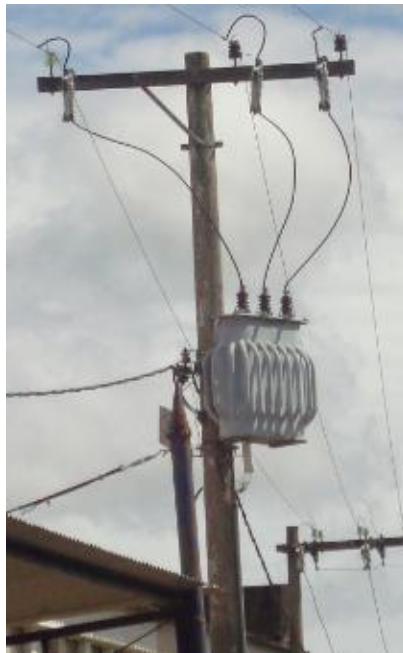
Figura 3 - Transformador de 45 kVA.
