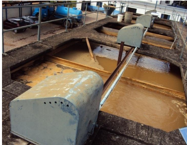
Figura 8 - Tanque com misturadores. Fonte: Da própria autora.
