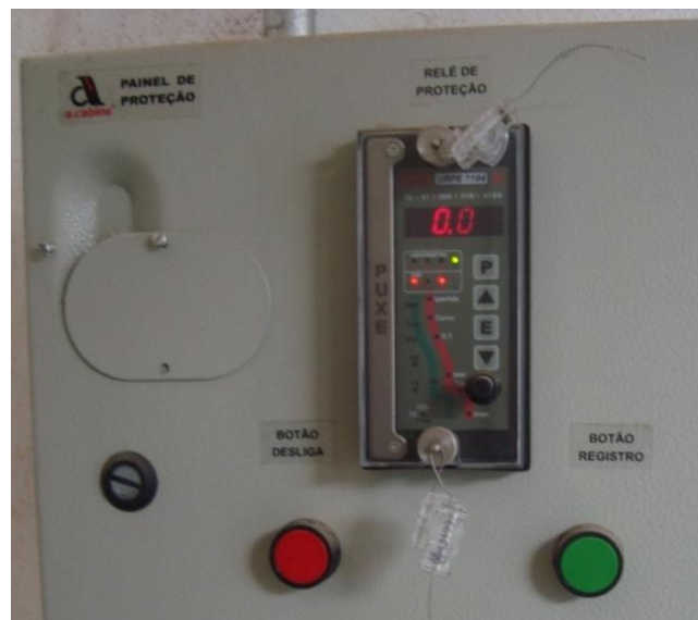
Figura 1 - Relé de proteção. Fonte: Da própria autora.
