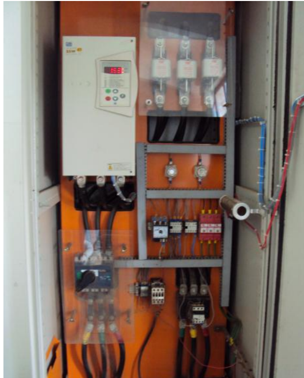
Figura 25 - Painel para acionamento do motor de 125 cv utilizando soft-starter . Fonte: Da própria autora.
