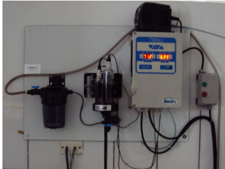
Figura 10 - Equipamento responsável pela adição de cloro na água. Fonte: Da própria autora.
