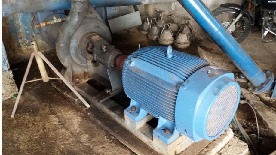
Figura 27 - Conjunto motor-bomba da ETA Santa Luzia. Fonte: Da própria autora.
