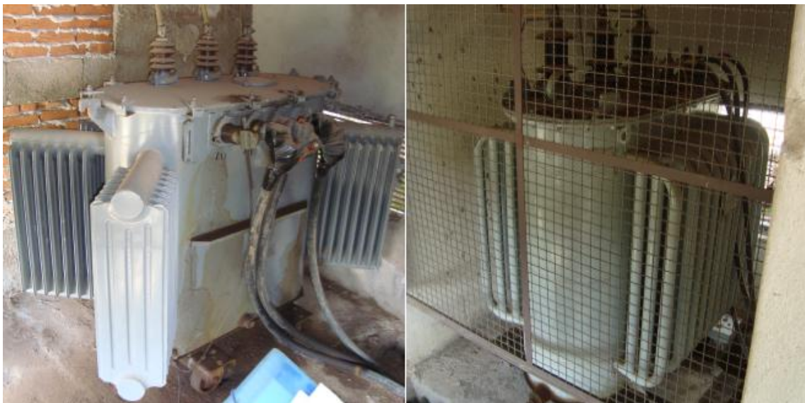
Figura 13 - Transformadores trifásicos: 300 KVA (à esquerda) e 150 KVA (à direita). Fonte: Da própria autora.
