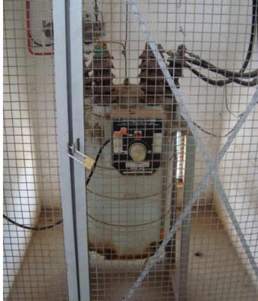
Figura 2 - Disjuntor a óleo.
