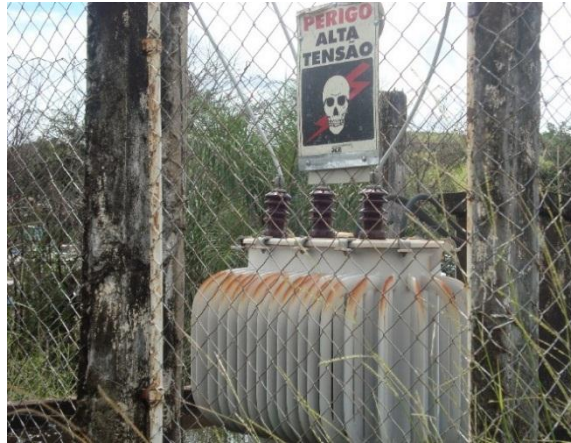
Figura 4 - Transformador de 112,5 kVA. Fonte: Da própria autora.
