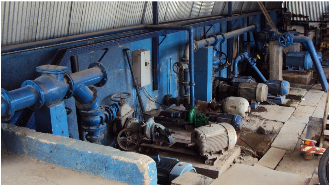
Figura 11 - Sistema de bombeamento de água do SAAE Formiga. Fonte: Da própria autora.
