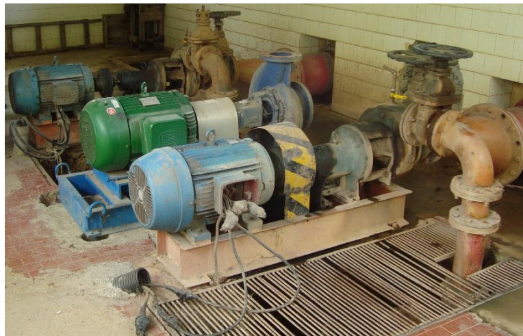
Figura 5 - Conjuntos motor-bomba utilizados para bombeamento. Fonte: Da própria autora.
