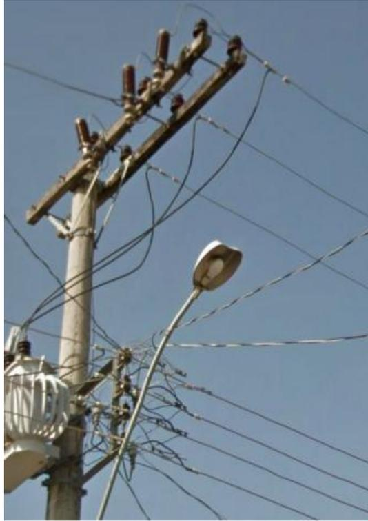
Figura 29 – Estrutura M2 de NBI 95 kV e transformador.
