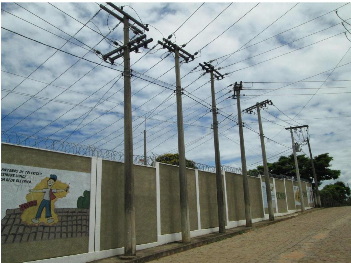
Figura 9 – Saída dos cinco alimentadores da SE de Formiga.
