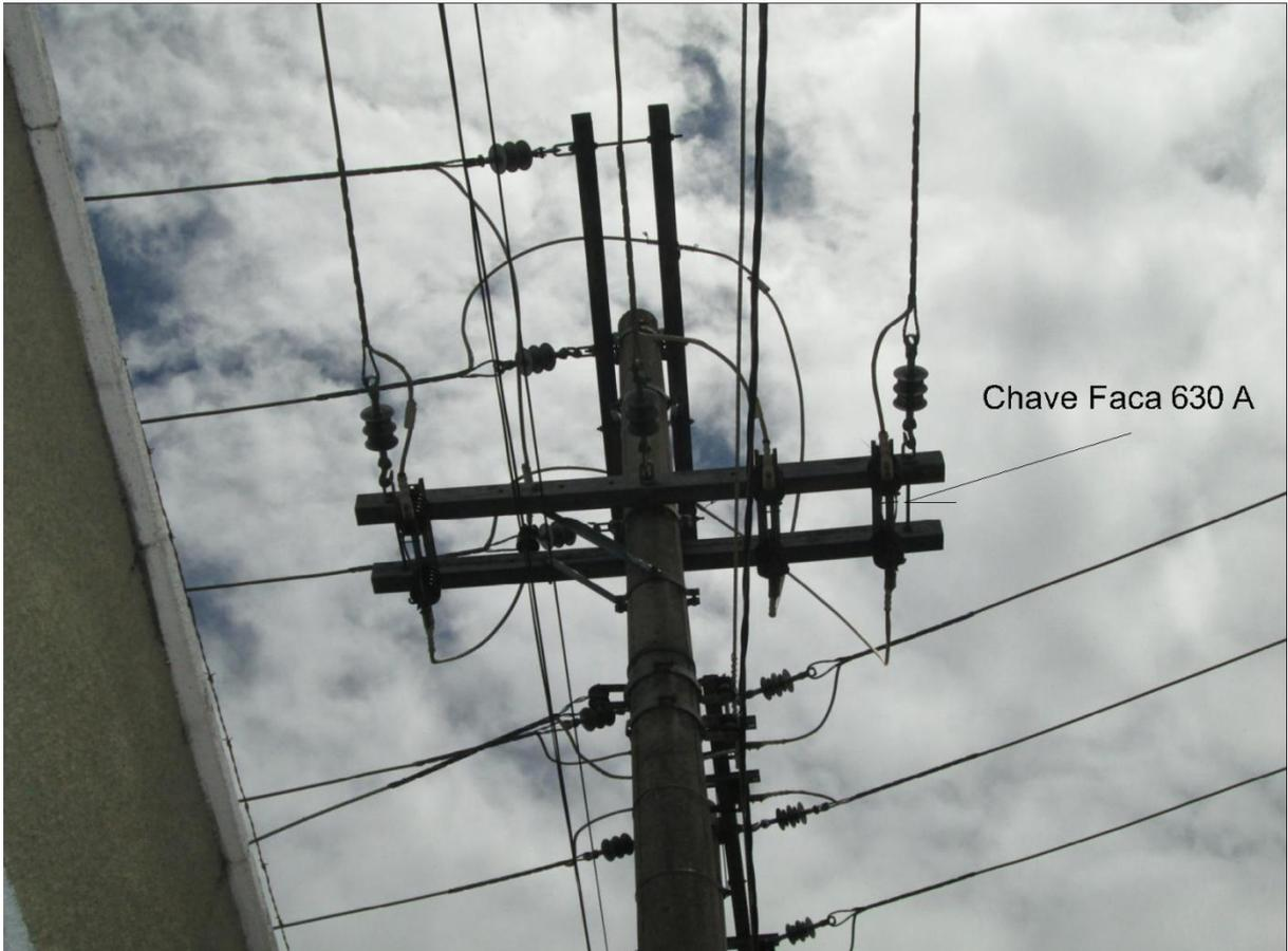
Figura 10 – Chave Faca 630 A na saída do FMA 03.
