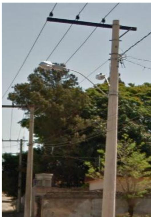
Figura 28 – Estrutura M1 de NBI 170 kV.
