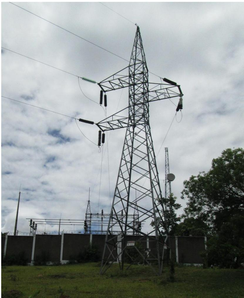
Figura 8 – Entrada da linha de subtransmissão na SE de Formiga.
