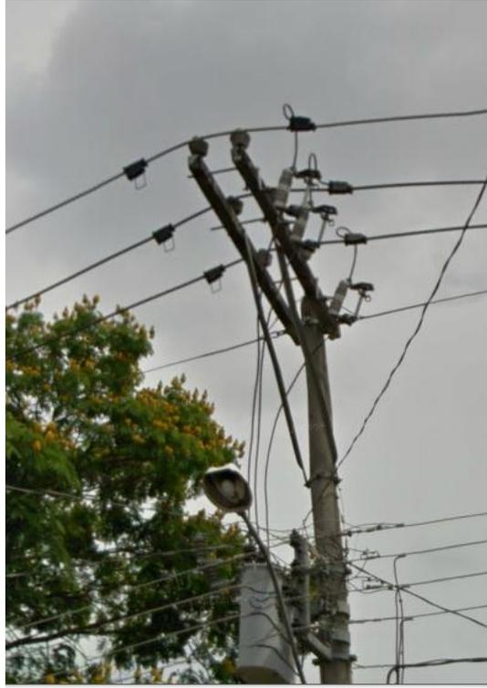
Figura 33 – Estrutura B2 para cabo protegido.
