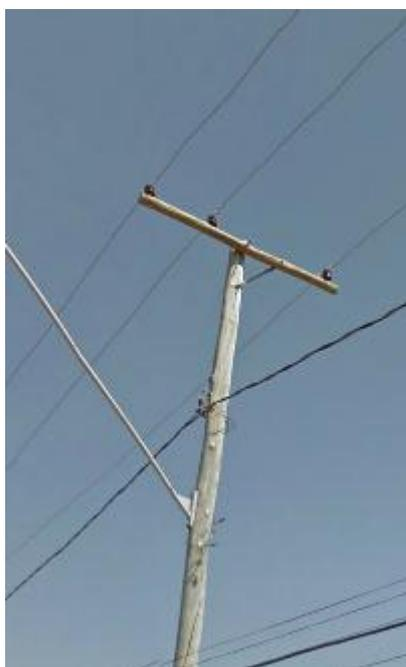
Figura 22 – Estrutura N1 em poste de madeira, NBI 300 kV.
