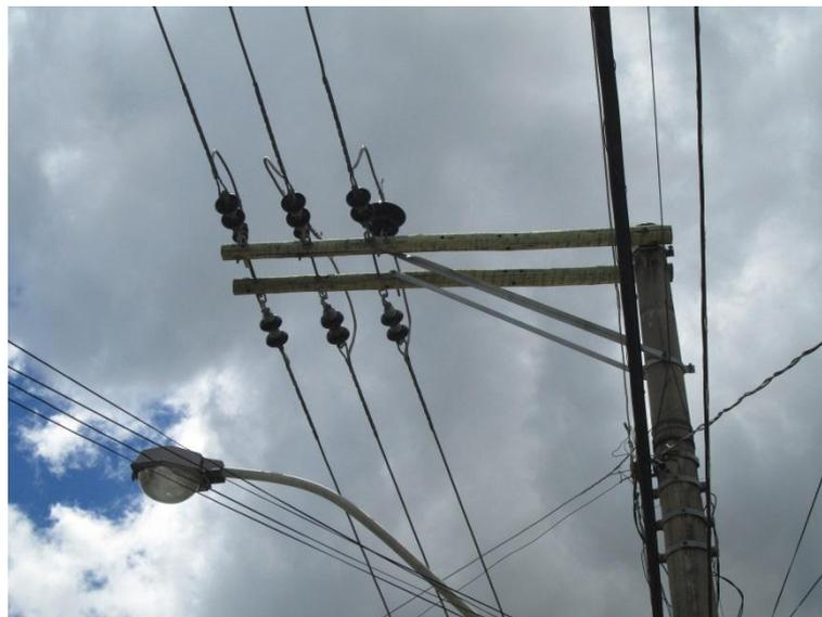
Figura 36 – Estrutura B4 de NBI 170 kV.
