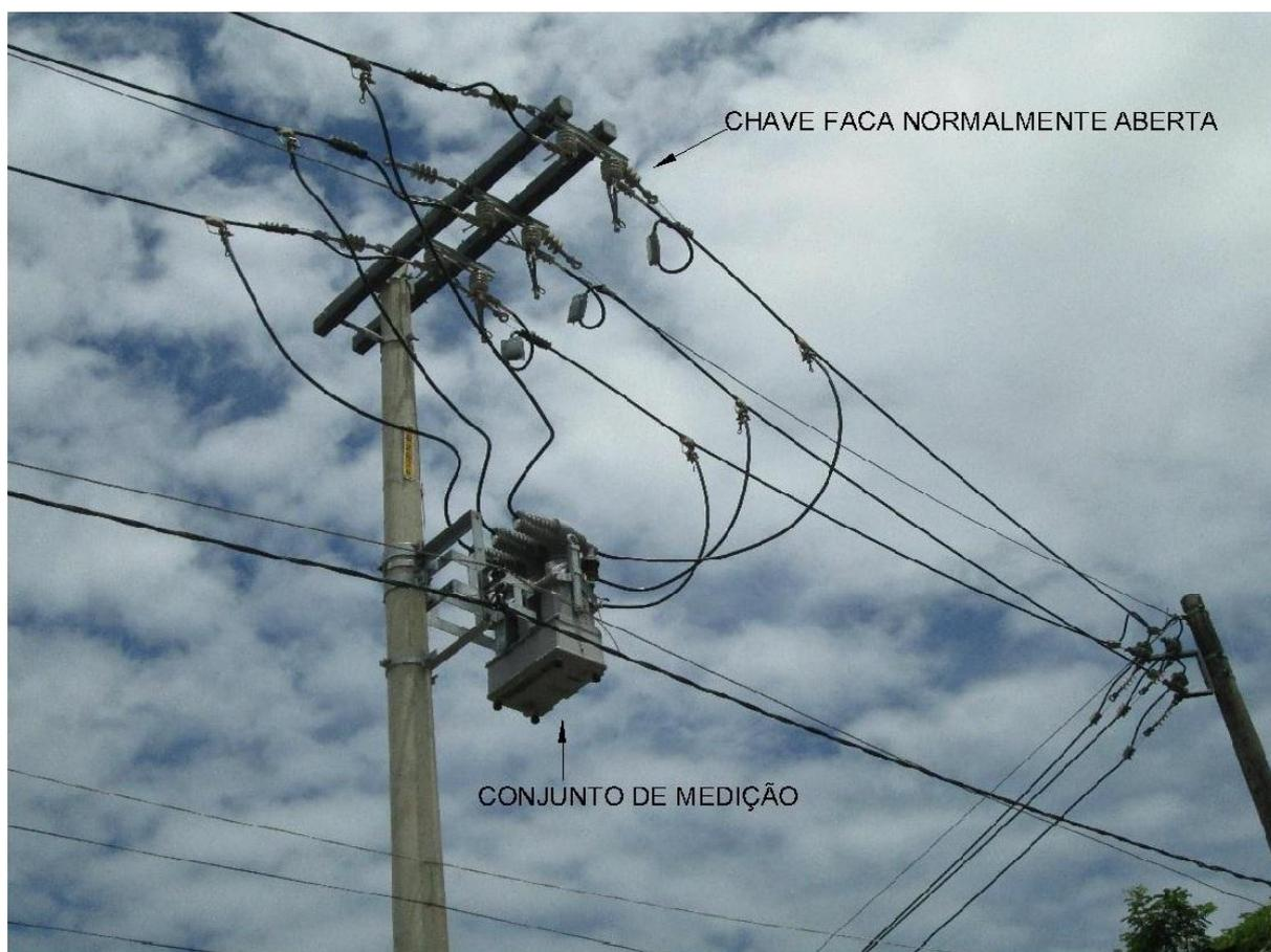
Figura 11 – Conjunto de medição na saída da SE.
