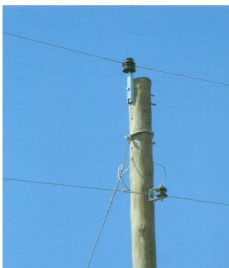
Figura 18 – Estrutura U1 com NBI de 300 kV.
