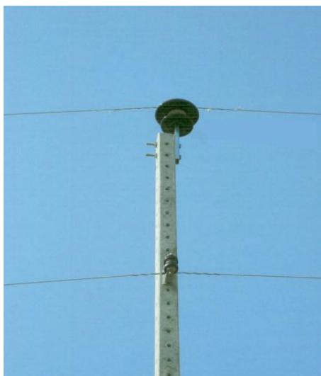
Figura 17 – Estrutura U1 com NBI de 170 kV.
