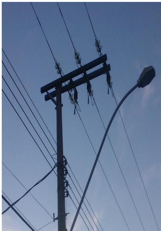
Figura 31 – Estrutura M4 de NBI 170 kV e chave faca aberta.
