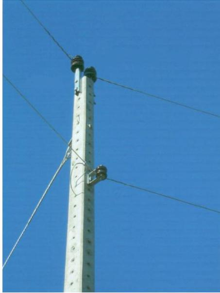
Figura 19 – Estrutura U2 meio de rede com NBI de 95 kV.
