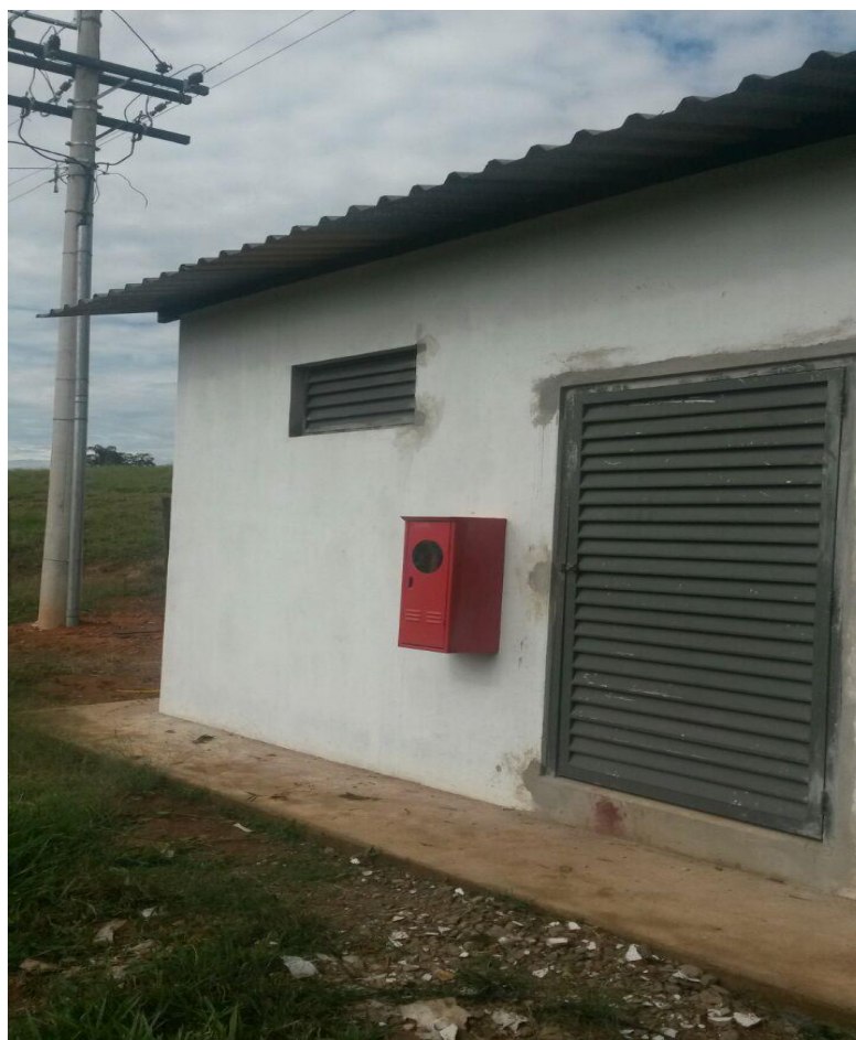
Figura 10 - Subestação em alvenaria.
