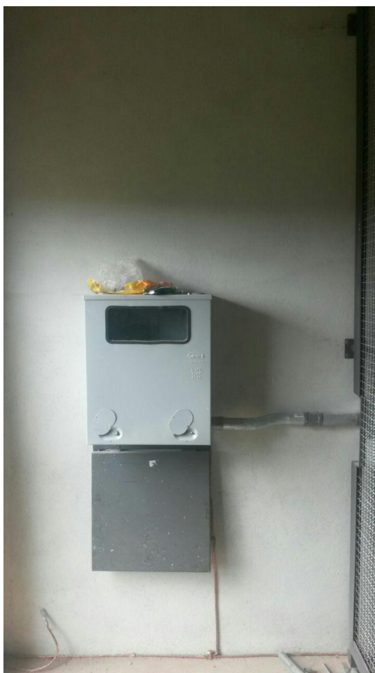
Figura 38 - Instalação de caixa de medição CM-4
