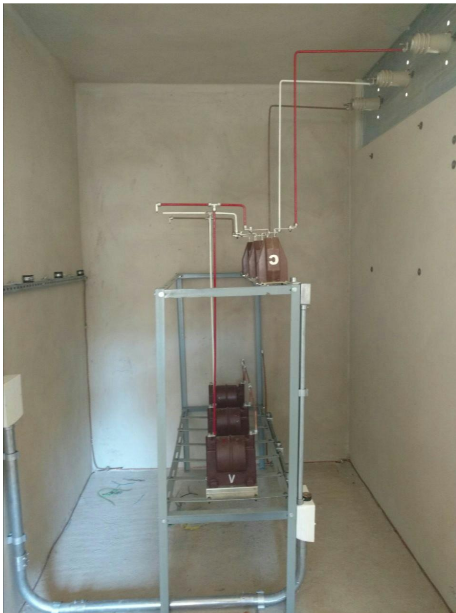
Figura 37 - Execução de baia de proteção de Subestação
