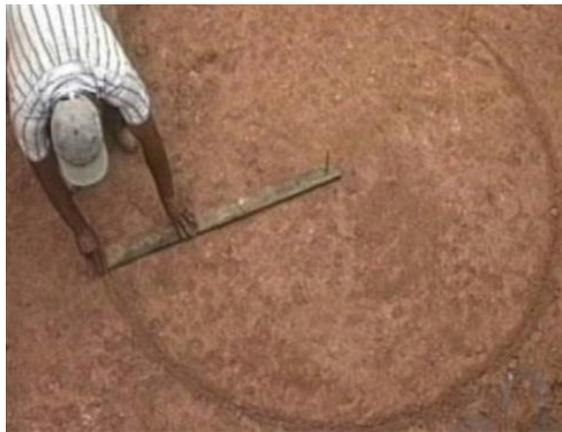
Figura 18- Marcação da base de concreto.
