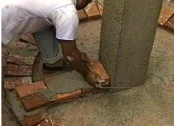
Figura 20- Construção da parede divisória.
