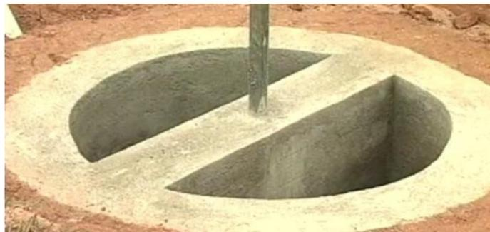
Figura 21- Parede da câmara de fermentação e parede divisória construída.
