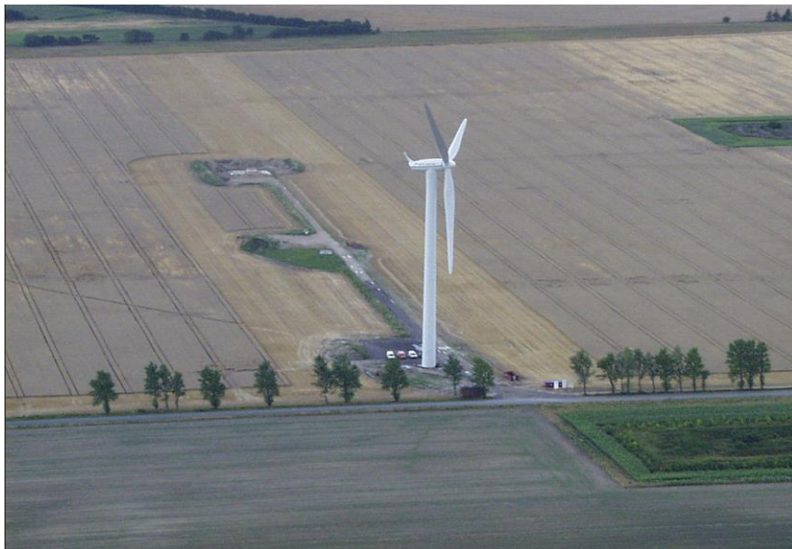
Figura 15 - Turbina NEG Micon.
