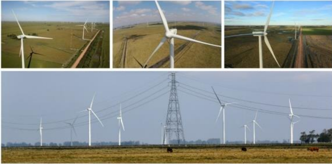
Figura 8 - Parque eólico de Geribatu.
