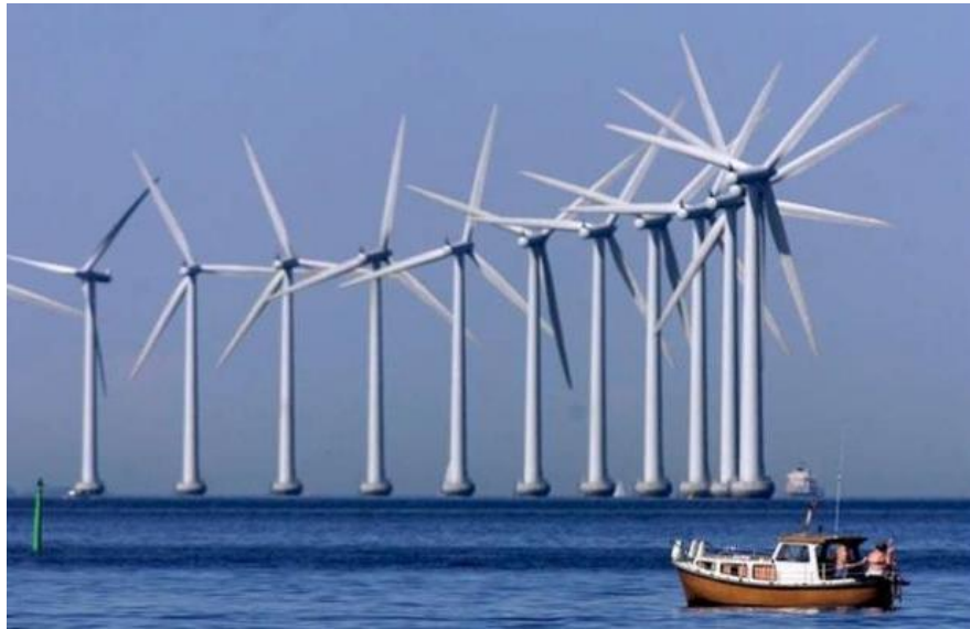
Figura 27 - Parque eólico offshore .
