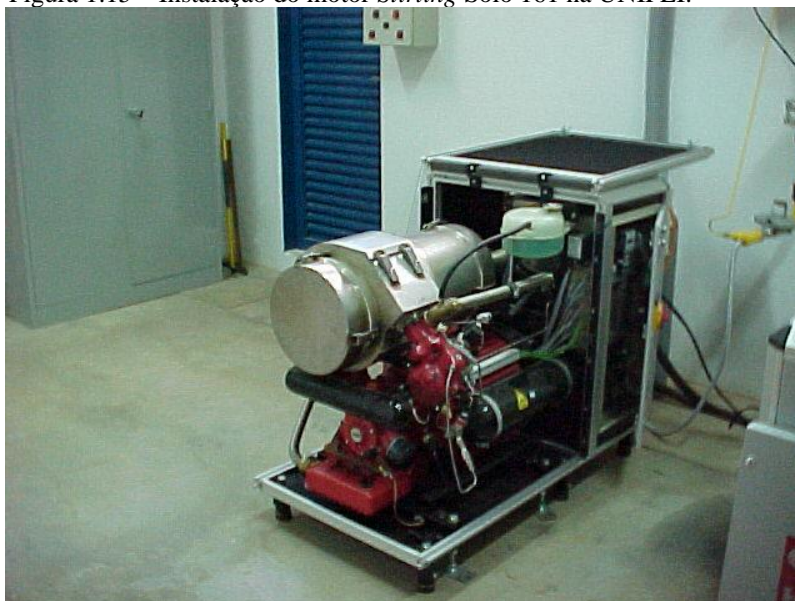
Figura 1.15 – Instalação do motor Stirling Solo 161 na UNIFEI.
