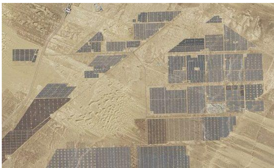
Figura 27- Parque solar Longyangxia Dam, China.
