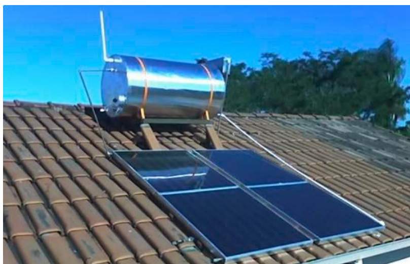
Figura 6 – Sistema de aquecedor solar residencial.
