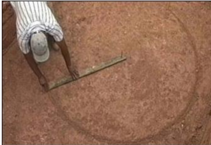
Figura 14 - Marcação da base circular com o gabarito de madeira.
