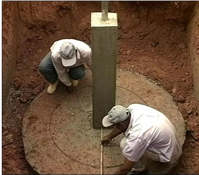
Figura 16 - Marcação da circunferência para a construção da parede cilíndrica.
