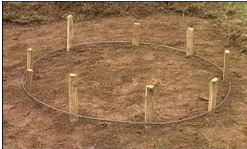
Figura 15 - Construção do vergalhão de ferro que auxiliará na construção da parede circular.
