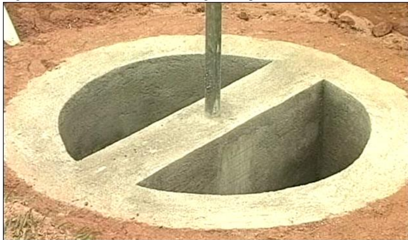
Figura 18 - Parede da câmara de biodigestão e parede divisória construídas.
