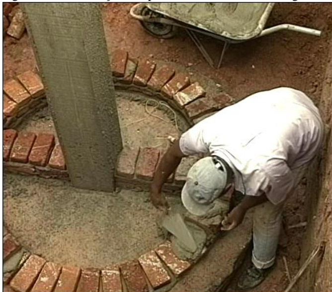
Figura 17 - Construção das paredes da câmara de biodigestão.
