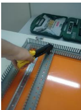
Figura 14: Fixando canaletas e trilhos.
